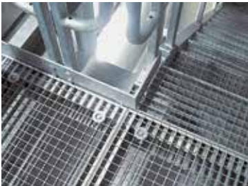
Fig. 35 : garde-pieds sur la construction
