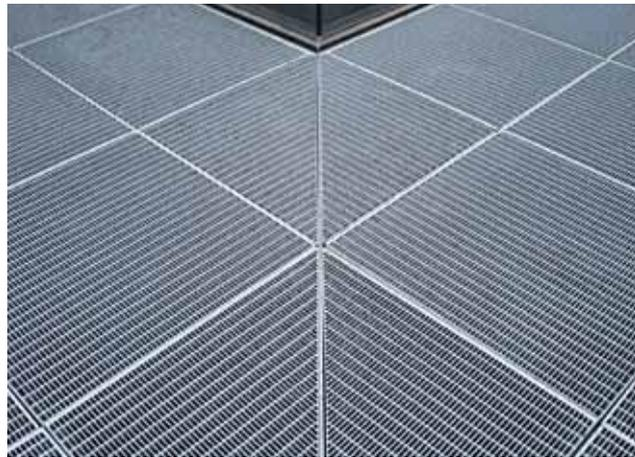
Bild 22: Schrägschnitt bei einem Gitterrost
